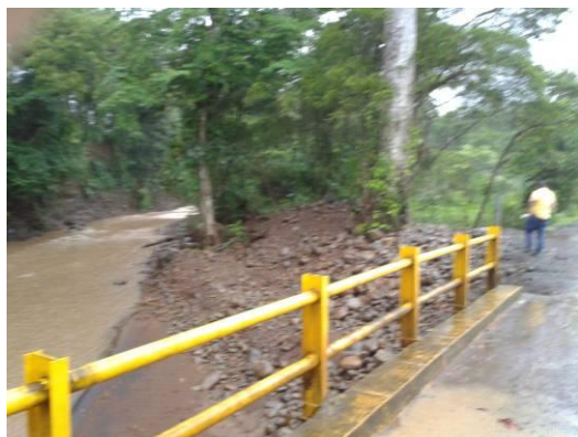
Relleno de acceso del puente entre Las Palmas y La Lucha, recuperando el paso seguro.
