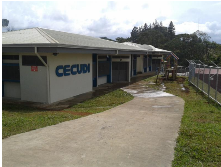
Vista costado noreste del Edificio
