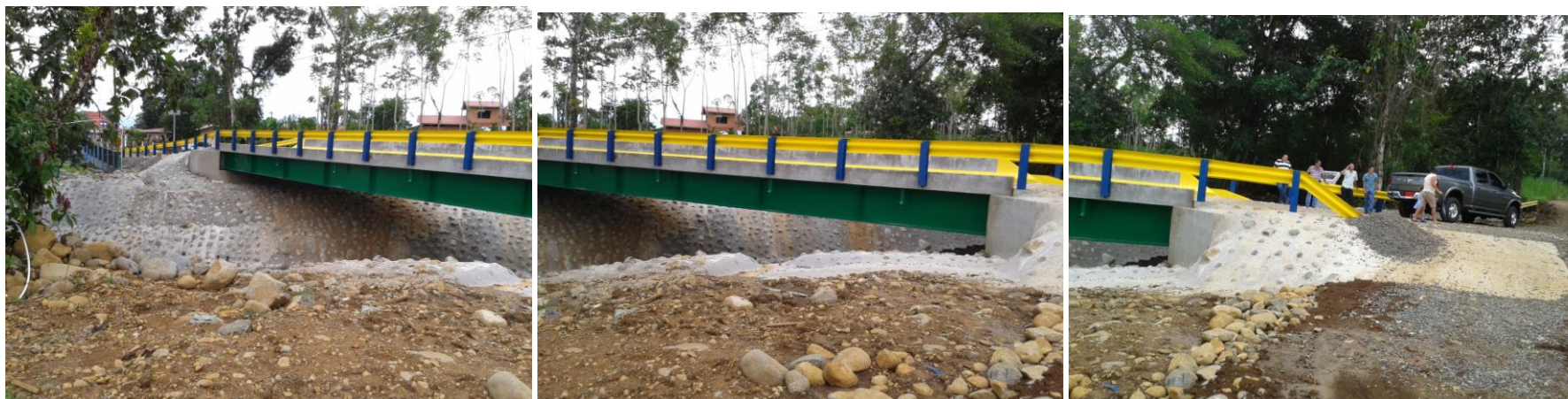
Vista global de la Estructura del puente
