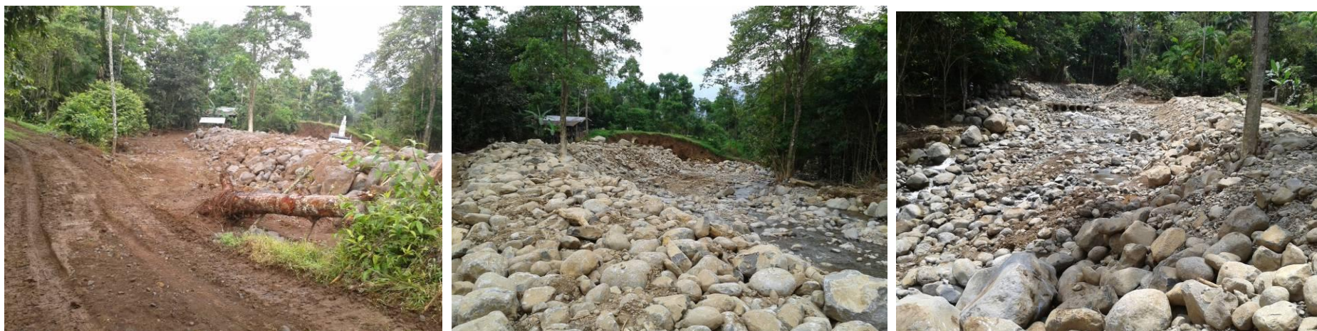
Conformación de dique a lo largo de la margen izquierda, Aguas Abajo del Paso Vado
