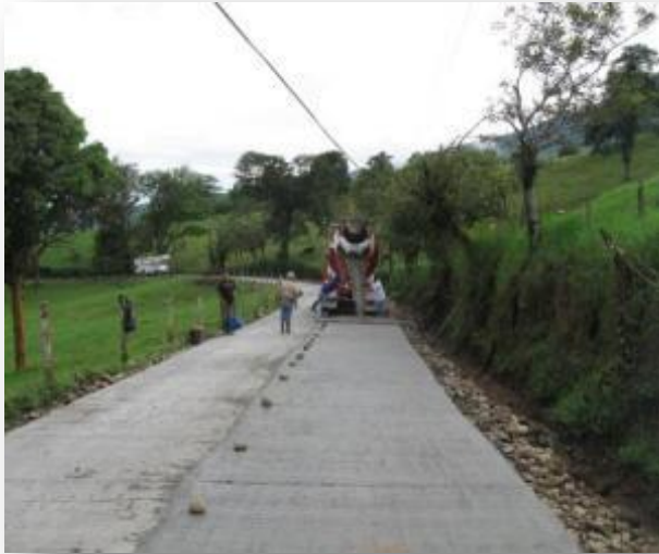
Losa Concreto, San Vicente de Ciudad Quesada. Camino 2-10-007
