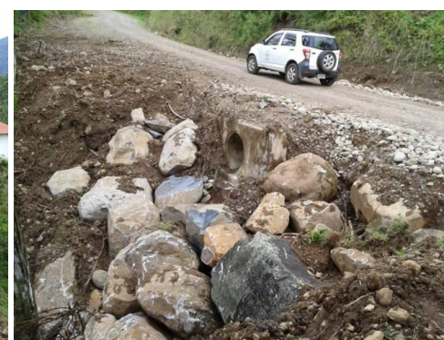
Reconstrucción y protección del principal paso de alcantarilla seriamente afectado por un gran deslizamiento.
