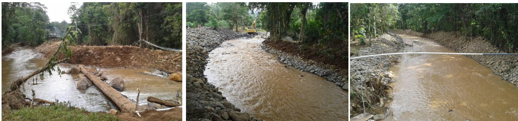
Sitio de intervención donde se aprecia la conformación realizada, limpieza de cauce y mejoramiento de sección.
