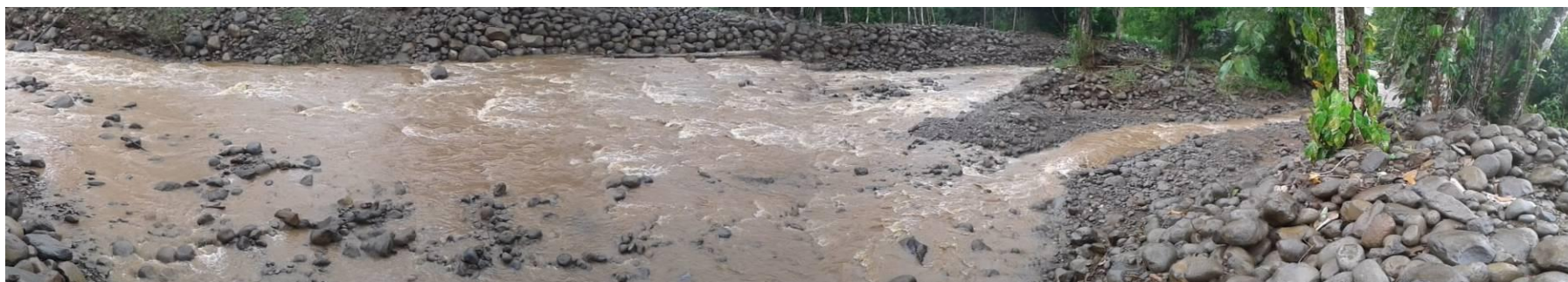
Dique en margen izquierda y habilitación de brazo desfogue
