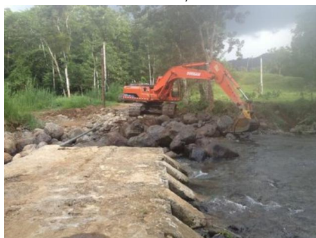
Relleno de acceso del puente entre Las Palmas y La Lucha, recuperando el paso seguro.
