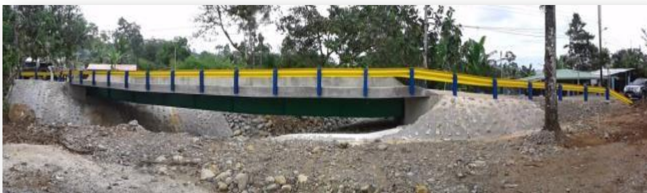
Vista Global del puente, escolleras, aproximaciones y barandas.
