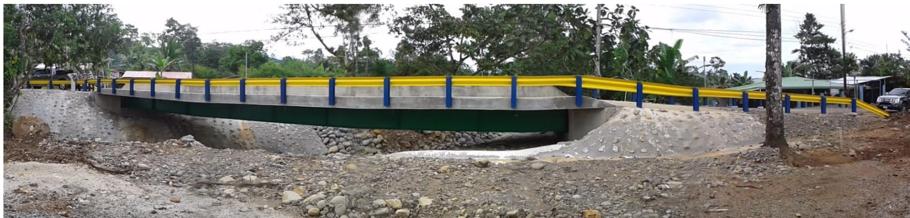
Vista Global del puente, escolleras, aproximaciones y barandas.
