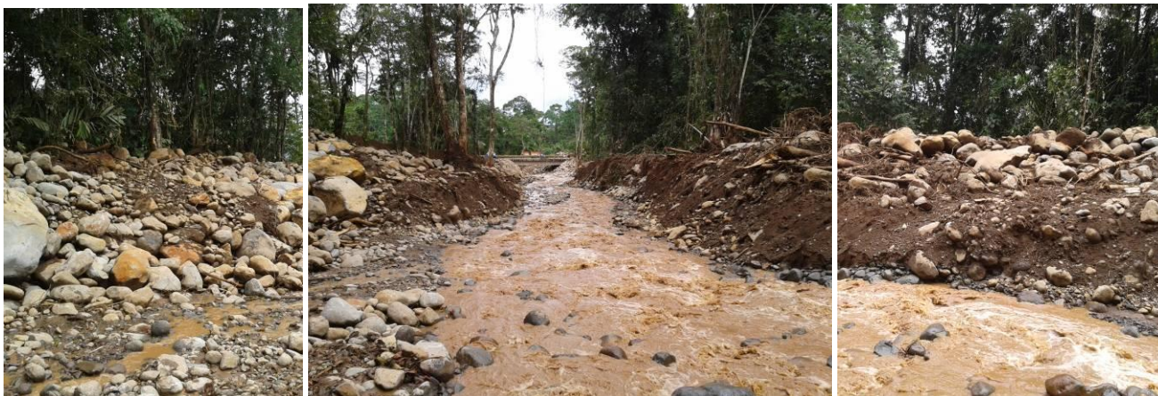
Proceso remoción de troncos-escombros y apilamiento de material en ambas márgenes, aguas arriba del puente sobre Ruta Nacional N°702
