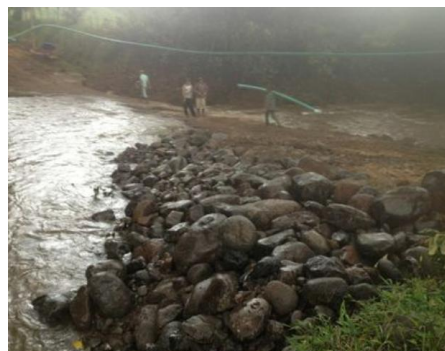
Relleno de acceso del puente entre Las Palmas y La Lucha, recuperando el paso seguro.
