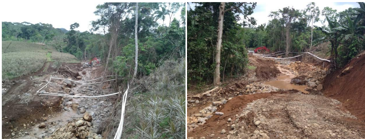
Trabajos aguas arriba y abajo del paso de tuberías de agua potable, en donde se realizó limpieza de cauce y confirmación de material hacia ambas márgenes
