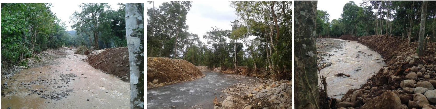
Ultimo sector aguas abajo comprendido por esta máquina, en donde culminó con recaba, limpieza y apilamiento de material en ambas márgenes.
