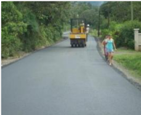
Carpeta Asfáltica, Santa Rita de Florencia:
