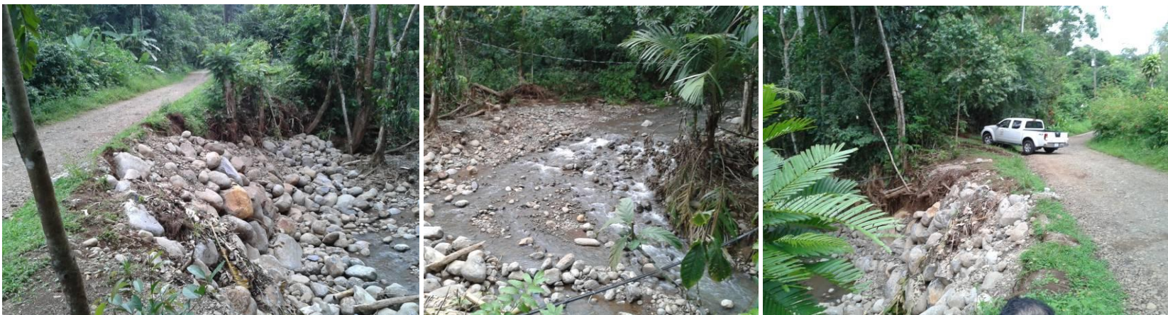
Material apilado a lo largo de la margen derecha, para protección del camino 2-10-212.
