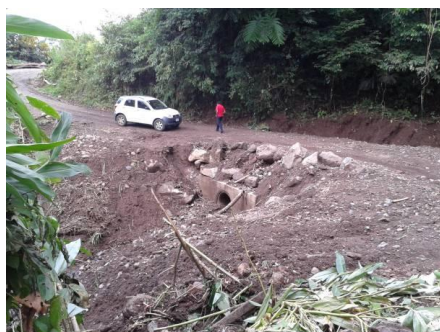
Otros pasos de alcantarilla cercanos, en los que se realizó el trabajo de remoción de escombros y protección de las estructuras.
