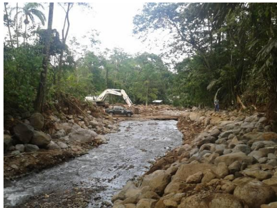
Trabajos aguas arriba del paso vado
