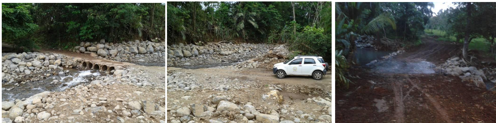
Sitio donde se ubicaba el puente colgante peatonal, habilitándose un paso vehicular provisional.
