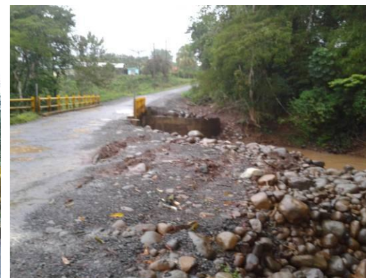
Relleno de acceso del puente entre Las Palmas y La Lucha, recuperando el paso seguro.
