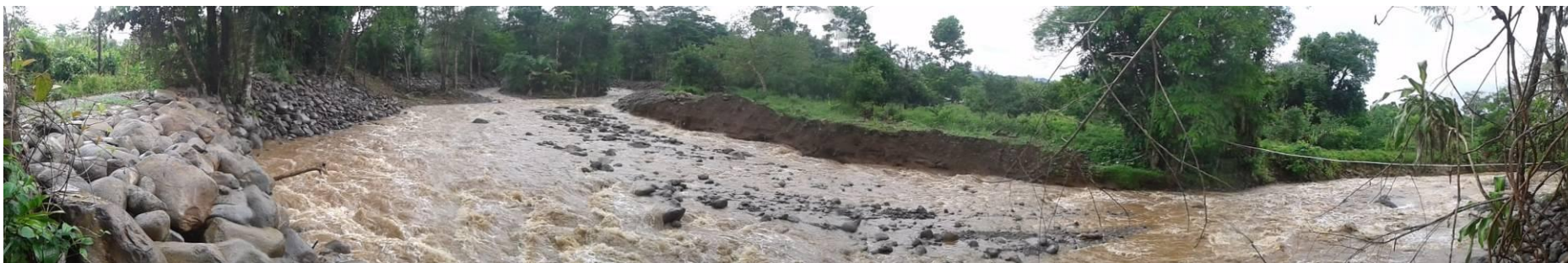
Dique construido en la margen derecha a lo largo del camino Cantonal 2-10-214, así como el considerable mejoramiento del ancho de la sección
