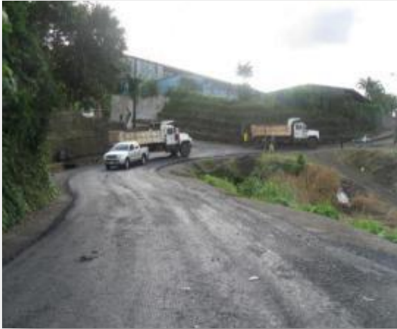
Carpeta Asfáltica, Calle El Tránsito, San Martín de Ciudad Quesada. Camino 2-10-153
