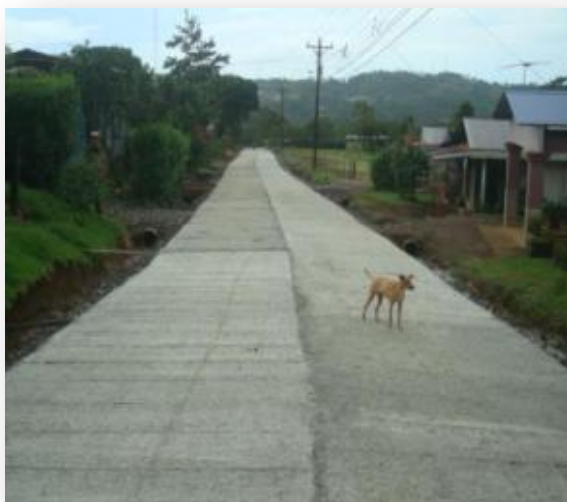
Losa de Concreto, San Luis de Ciudad Quesada:
