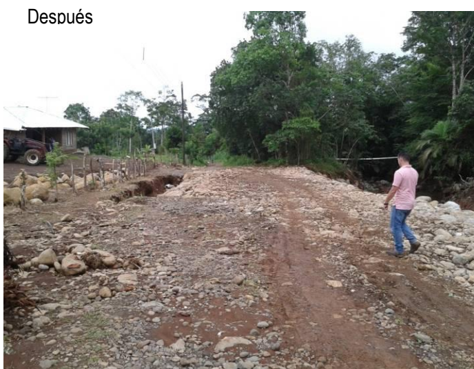
Tramo de Camino recuperado con la conformación y relleno de material del mismo sitio
