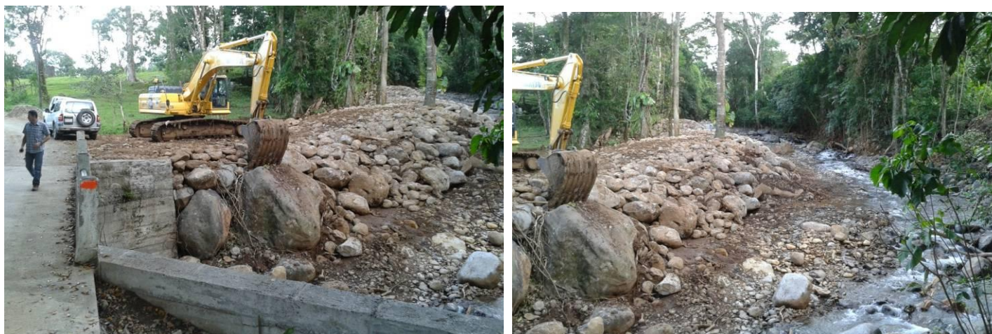
Remoción de material, mejoramiento de la sección hidráulica, canalización y construcción de un dique para protección de puente existente
