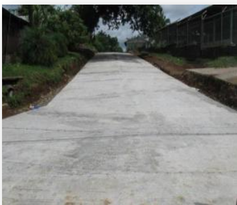
Losa de Concreto, El Saíno de Pital. Camino 2-10-298
